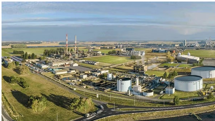
[TotalEnergies의 Grandpuits 플랫폼]
